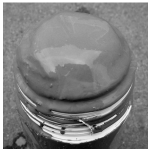
写真-4. 加圧後のグラウト状況
