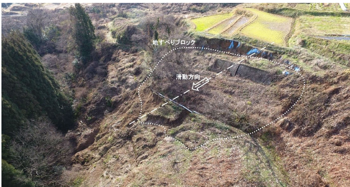
図-1 地すべりブロック全景
